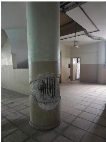
Pilar com armadura exposta Fonte: Acervo pessoal
