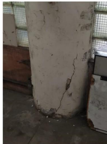
Trinca setorizada em um pilar Fonte: Brasil Perícias
