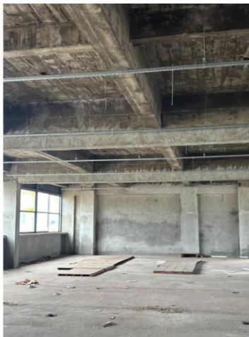
Laje com intenso processo de infiltrações Fonte: Acervo pessoal
