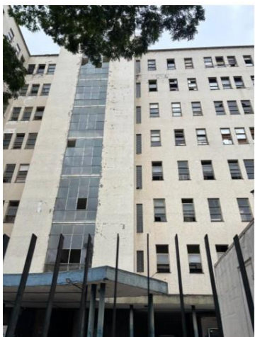
Fachada AG (ausência de pastilhas e parte de esquadrias) - Fonte: Acervo pessoal
